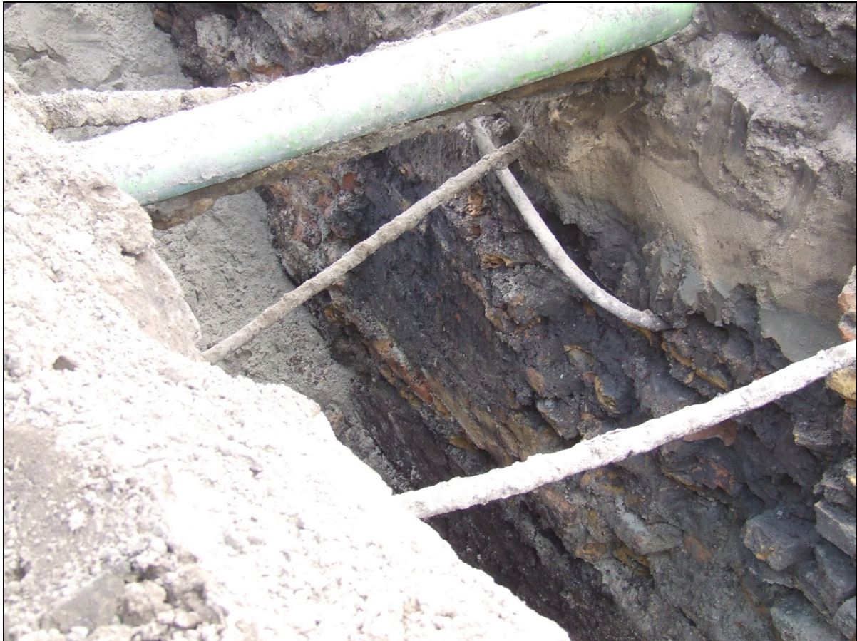
Afbeelding 4.11. Doorsnede van de funderingen van het oude raadhuis in het noordelijke profiel van de rioolsleuf, dat in de vorige eeuw voor de aanleg van een aantal leidingen deels was uitgebroken. Linksboven in het profiel de aanzet van de eerste dwarsmuur, rechtsonder is nog net de aanzet van de tweede dwarsmuur zichtbaar.
