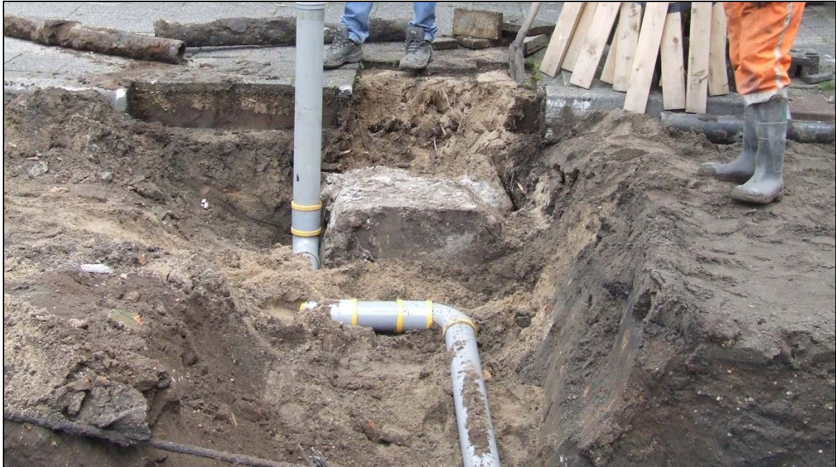
Afbeelding 4.15. De betonpoer (Spoor nr. 8), die onder het wegdek aan de noordzijde van de Kerkstraat werd aangetroffen. De nieuwe aansluiting werd noodgedwongen omgelegd, omdat de graafmachine moeite had om het blok te verwijderen.
