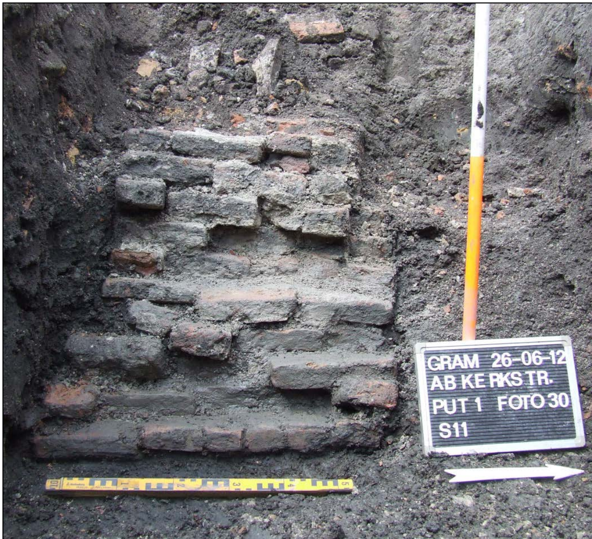
Afbeelding 5.7. Doorsnede van de kerkhofmuur (Spoor nr. 11). De foto is genomen vanuit oostelijke richting.
